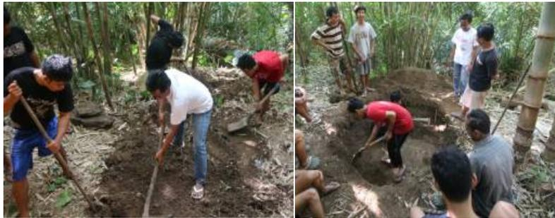
Gambar 1 Pembuatan Galian untuk Reservoir
