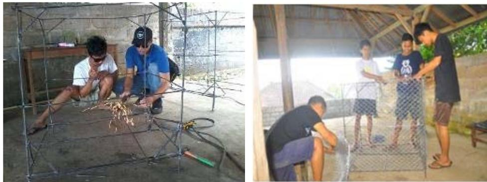
Gambar 3. Proses pembuatan kerangka tempat sampah
